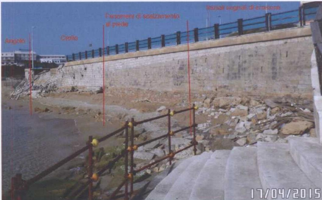
La tipologia costruttiva del muro di sostegno non risulta omogenea mostrando vari interventi intervenuti in vari tempi e con modalità costruttive diverse:
